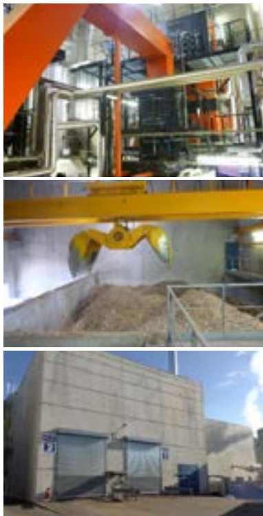
Chaufferie Bois Energie Papeteries Des Vosges (PDV)
