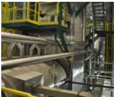
Chaudière SIL – site SAIPOL à Lezoux
