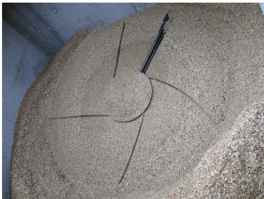
Figure 11. Dessilleur rotatif alimentant en plaquettes la visse sans fin (source: chaufferie au bois du Col de Romeyère - Rencurel)
