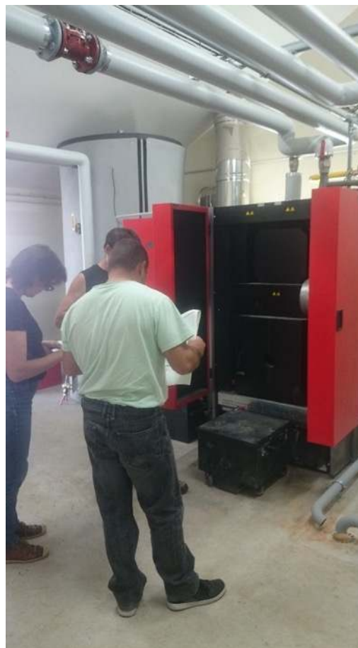
Photo de suivi d'installation (Source : CRER)
