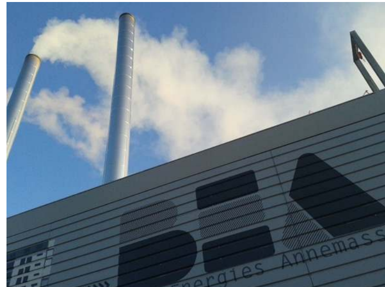
Photo de cheminée de la chaufferie bois d'Annemasse (3,5 MW bois) (Source : CIBE)
