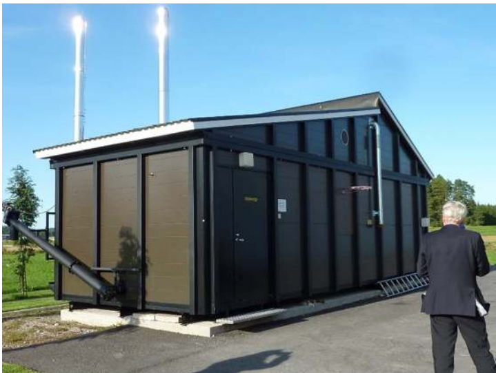
Photo d'une chaudière container à Porvoo (Finlande, 80-500 kW bois) (Source : CIBE)
