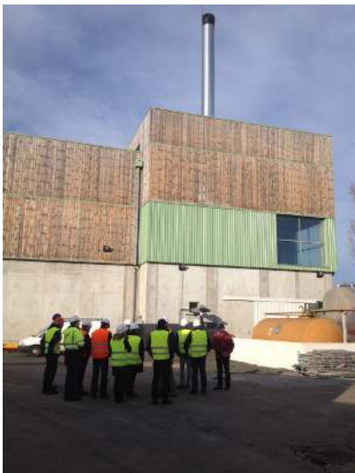
2015 Visite de la chaufferie Biomasse MICHELIN CHOLET
