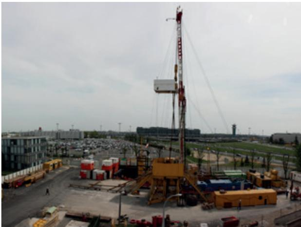
Fin 2010, une installation de géothermie profonde a été créée sur le site de l'aéroport de Paris-Orly, pour assurer le chauffage d'une partie de ses installations (aérogare et bâtiments tertiaires).
