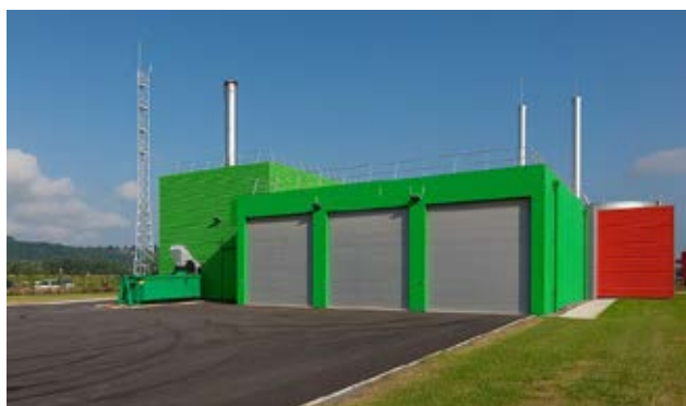
Chaufferie bois de Safran Helicopters Engines à Bordes (64)
