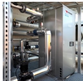
Figure 59: groupe froid à absorption (Serm)
