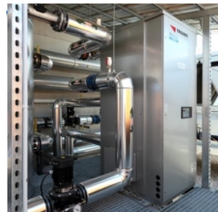
Figure 59: groupe froid à absorption (Serm)
