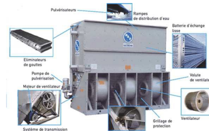
Figure 61 : Tour fermée - principe et équipement
