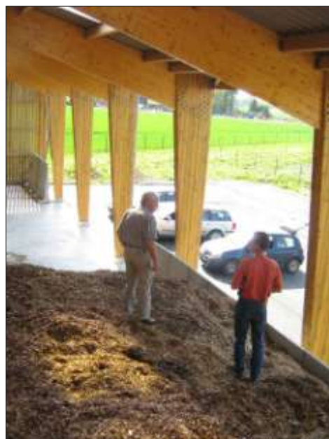
Sous la plate-forme collective d'Athis ▼
