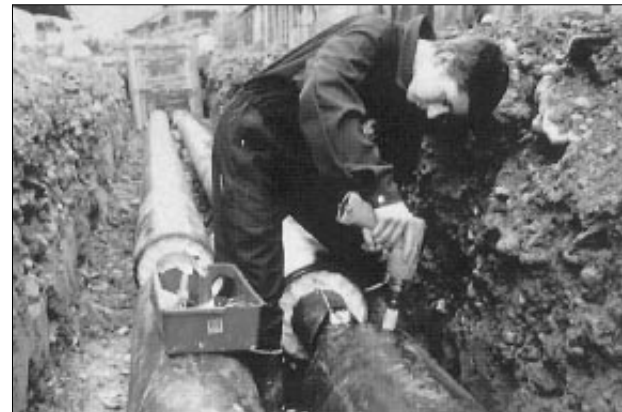
Isolation subséquente des joints soudés sur le chantier
