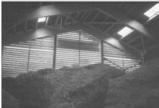
Halle de stockage de plaquettes de bois
