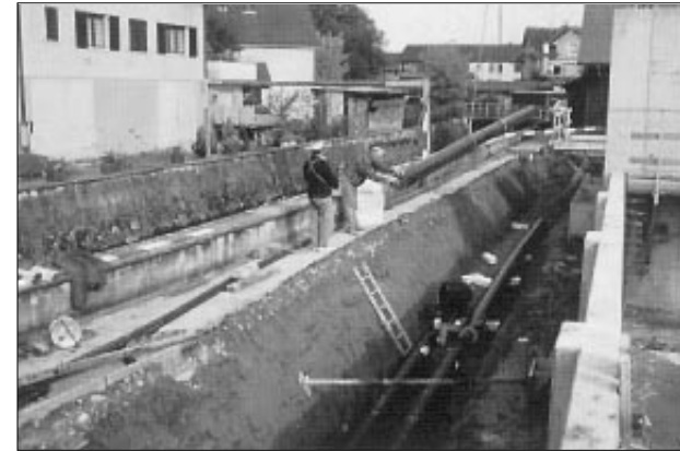
Pose des conduites dans la fouille
