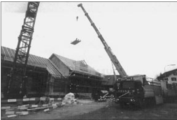
Amenée des éléments de la chaudière dans la chaufferie à l'aide d'une grue sur pneus
