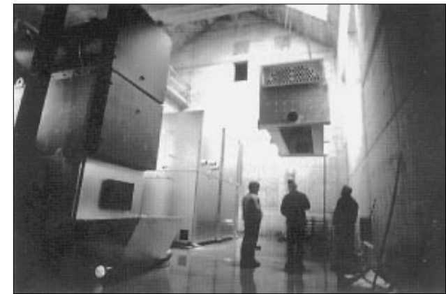
Foyer à poussée inférieure dans la centrale thermique (montage)
