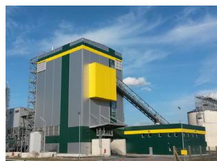
Centrale biomasse à Vieille-Saint-Giron (Landes)
