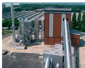
Centrale biomasse à Cergy-Pontoise (Val d'Oise)
