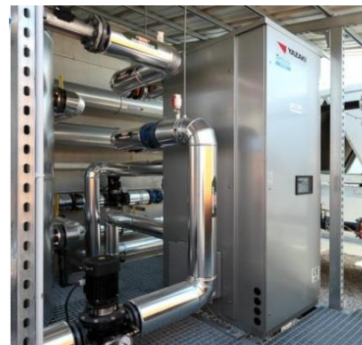
Figure 44: groupe froid à absorption (Serm)
