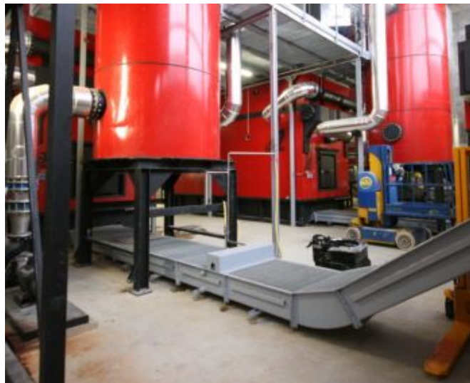
Figure 3-2: Convoyeur à cendres (source Compte.R)
