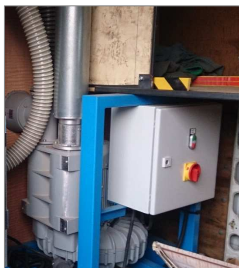
Centrale d'aspiration 7,5 kW
