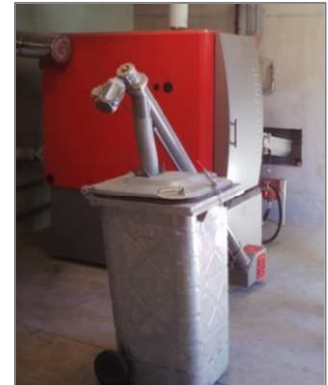
Poubelle à cendres d'une chaudière de 150 kW
