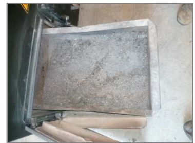
Bac à cendres d'une chaudière de 400 kW
