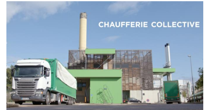
Mise en place en réception de chaufferie (au déchargement, sur tapis, ...)
