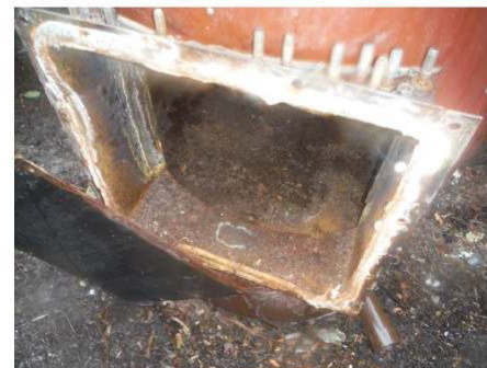
Photo 21 : Face interne de la trappe de visite au sol – corrosion de surface
