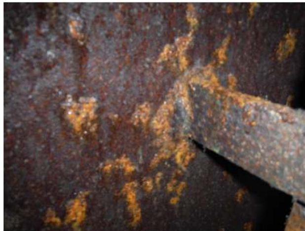
Photos 37 et 38 : Echelle à crinoline – revêtement de protection vieillissant et quelques points de corrosion en surface
