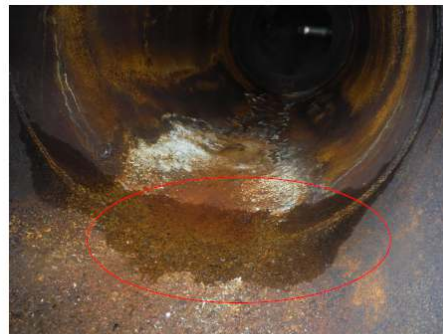
Photo 21 : Face interne de la trappe de visite au sol – corrosion de surface
