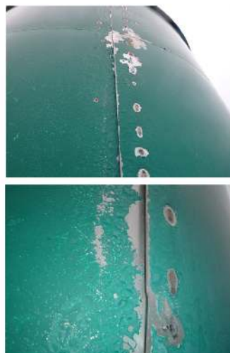
Photos 26 et 27 : Renaisse métallique au sommet – liaison défectueuse et revêtement de protection vieillissant
