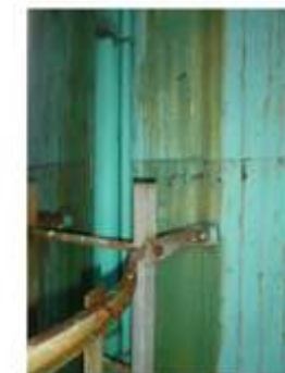
Photos 48 et 49 : Echelle à crinoïde à 9m – corrosion
