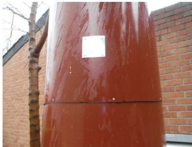
Photos 10 et 11 : Face externe en partie basse - bon état visuel de la protection calorifuge
