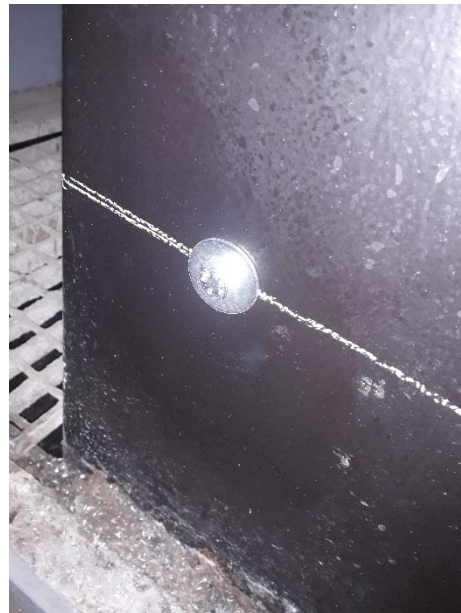
Photo 9 : Percements fermés à l'issue de l'essai à l'aide d'un boulon et d'une rondelle pour garantir la totale étanchéité après remise en service de l'installation
