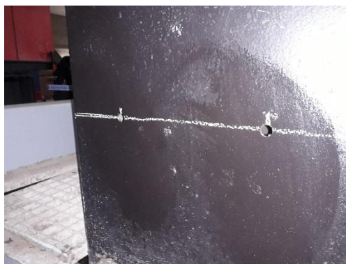
Photo 6 : Gaine après percements à l'aide d'un matériel fourni par le Prestataire (forêt et perceuse) permettant l'introduction d'une tige filetée boulonnée à chaque extrémité pour garantir l'étanchéité de la gaine après la remise en fonctionnement de la chaudière
