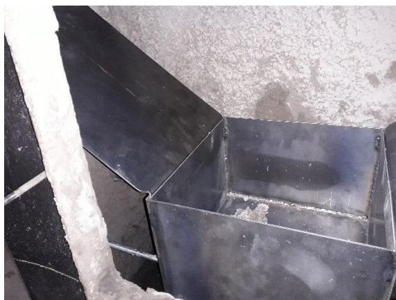
Photo 7 : Bac de réception des cendres multicycloniques reposant sur les tiges filetées avant remise en service de la chaudière biomasse
