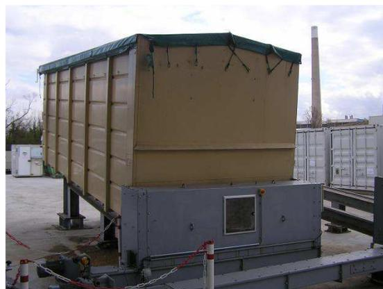
**Figure 36 - Vue de la chaudière (gauche) et du silo de stockage de combustible (droite)**
