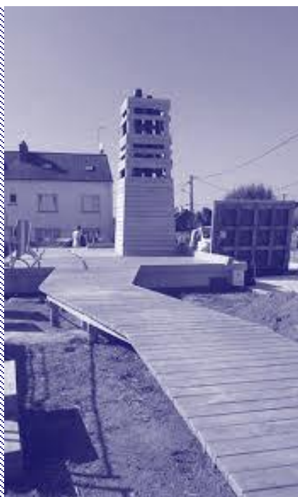
La chaufferie bois de Locmiquélic réalisée par la ville de Locmiquélic et exploitée par la SPL © agenda21.lorient.fr
