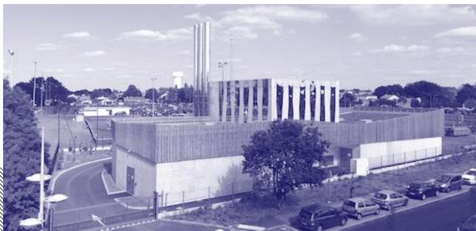
La chaufferie Rezé-Château © Idex
