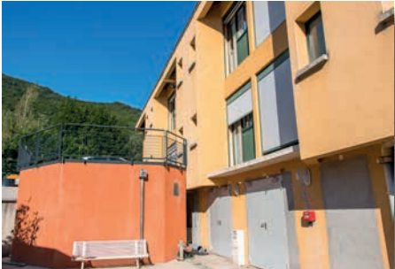
Local chaufferie (à droite, porte grise) + silo semi-enterré (à gauche, local orange)
