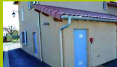
L'entrée de la chaufferie
