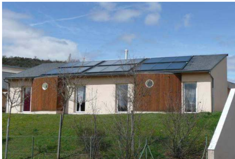
FIGURE 1 – Capteurs solaires – Maison d'accueil spécialisée à Chirac
