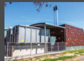
Chaufferie d'Estagel (source : Bois énergie 66)
