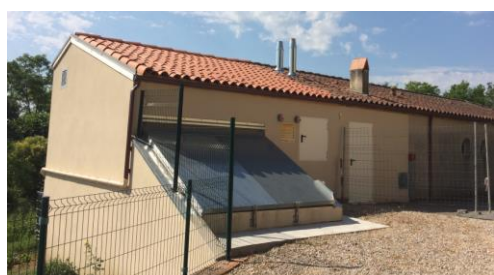
Trappe d'accès au silo bâti
