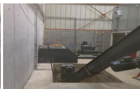
Vis sans fin Alimentation de la chaudière
