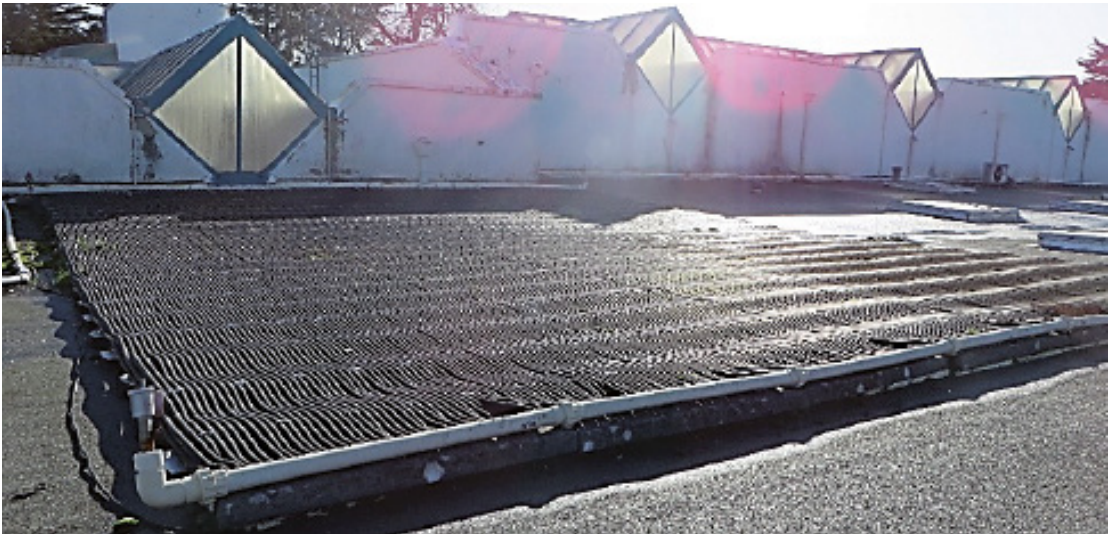
Figure 28 : Installation des capteurs thermiques basse température en toiture (site de Plougonvelin - 29)
