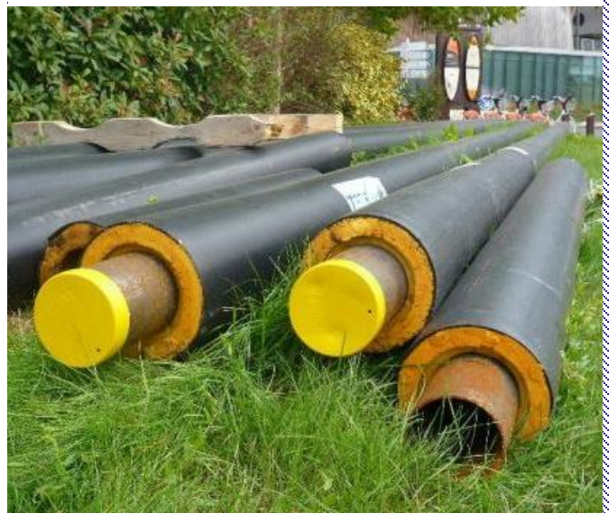
Canalisations isolées en attente de pose
