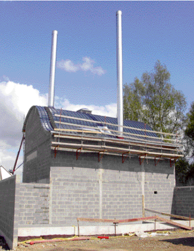
construction d'une chaufferie bois
