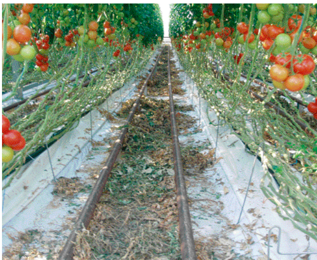
Tubes d'eau chaude placés au sol (entreprise Thomas, Finistère).
