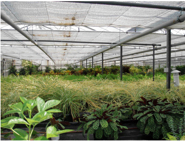
Ecrans thermiques pour diminuer la luminosité et garder la chaleur (serres municipales d'Angers, Maine-et-Loire).
