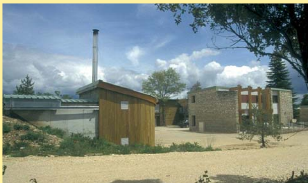
La chaufferie bois de Murs (Vaucluse, source : PNR du Luberon).
