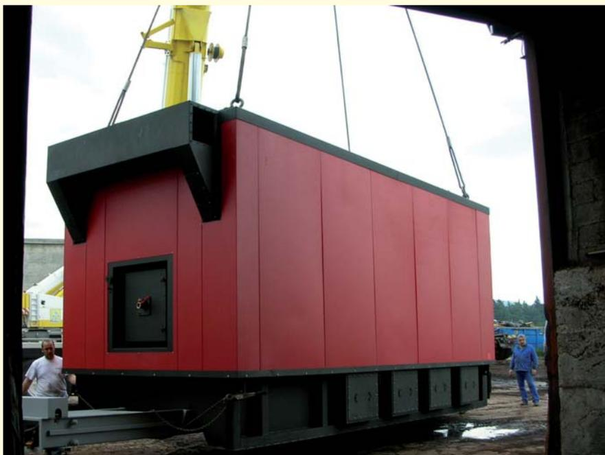
Chaudière biomasse de 7 MW en cours de montage.
