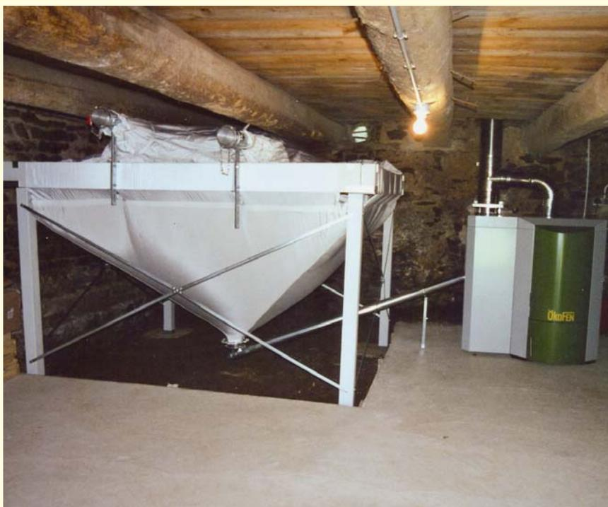
Chaudière à granulés et silo de stockage en toile.
