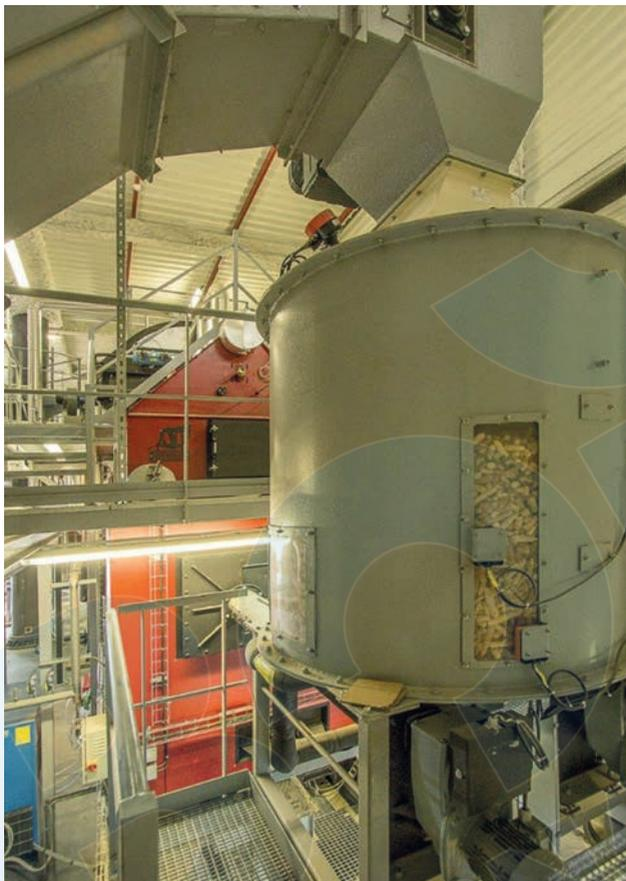
**Combustion de rafles de maïs chez Limagrain à Ennezat (Puy-de-Dôme) – 3,5 t/h de vapeur (alimentation en combustible au premier plan, chaudière en arrière-plan).**
