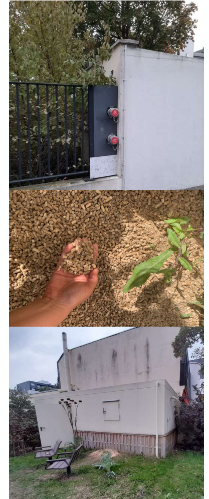
Visite chaufferie Courbevoie 10/06/2022
