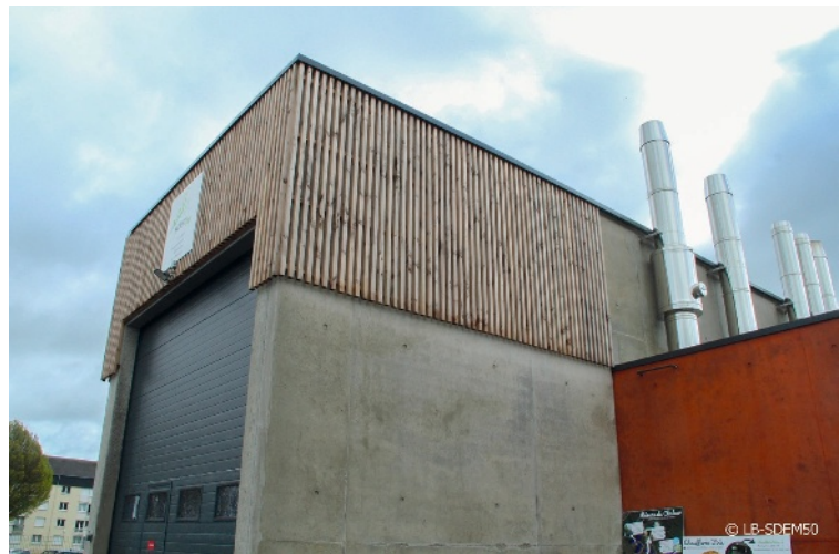
Chaufferie bois du réseau de chaleur de Coutances (Manche).
