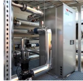
Figure 27: groupe froid à absorption (Serm)
