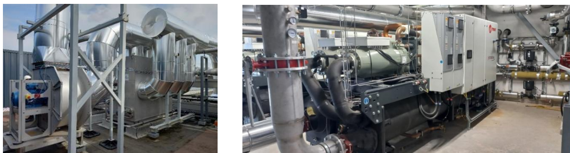
Figure 2 : Condenseur-laveur (à gauche) et groupe froid (à droite)
